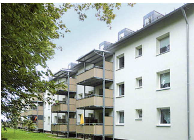
Insgesamt 108 Wohnungen hat die BlmA in Regensburg umfassend saniert. Dazu gehörten auch energetische Maßnahmen wie Wärmedämmung.
