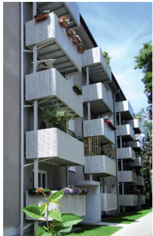
In Freiburg-Haslach hat die BlmA bei neun Mehrfamilienhäusern Balkone angebaut und saniert sowie alle Wohnungen modernisiert.
